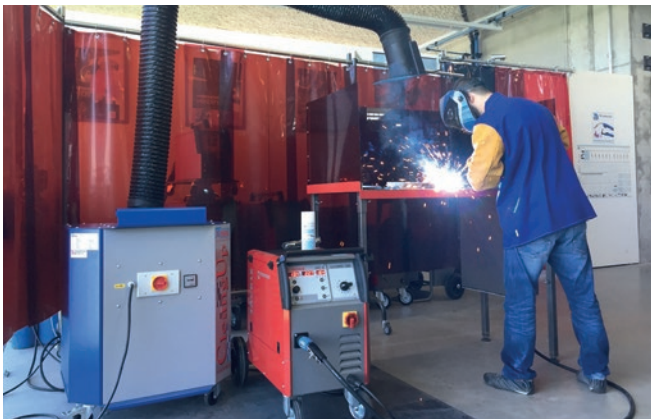
Direktabsaugung für metallverarbeitender Betrieb
