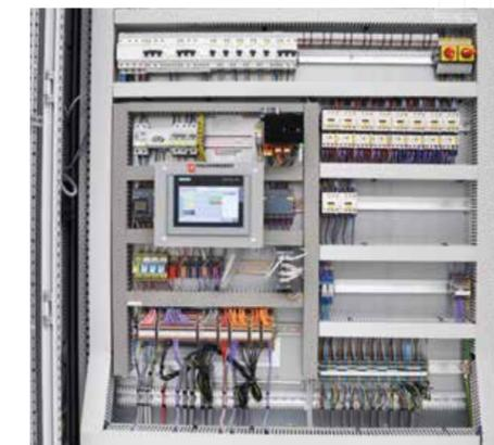
Zentrales Element des Hallenlüftungssystems ist die Steuerung. Das modulare Kompaktgerät filtert und klimatisiert die Luft in einem System.
